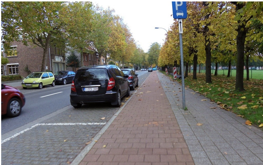
Figuur 15: Veltwijcklaan (Figuur 13:2): eenrichtingsfietspaden : 10/10 (255cm)
