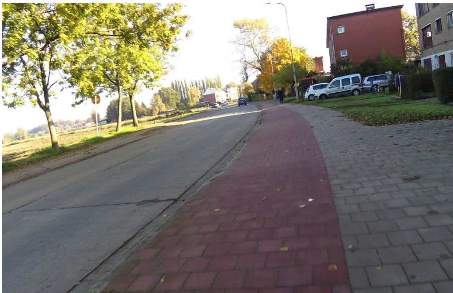
Figuur 11: Schriek (zie ook Figuur 9 : 3): score breedte 10/10 met 1,75m
