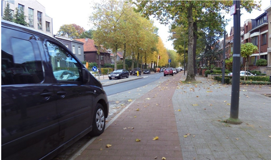
Figuur 12: Veltwijcklaan tussen Lindelei en Bistkapellei (zie ook Figuur 9 : 2): score breedte 3/10 met 1,55m voor een éénrichtingsfietspad, met een toegepaste breedteminering van 50cm op basis van onvoldoende schuwbreedte links van de fietser met hoge parkeerintensiteit.
