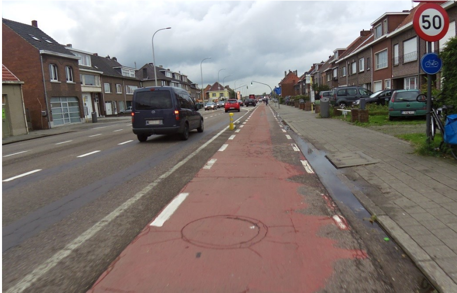
Figuur 14: Leugenberg (Figuur 13:1): tweerichtingsfietspad met zeer beperkte afseiding: 3,4/10 (45cm tussenbreedte)
