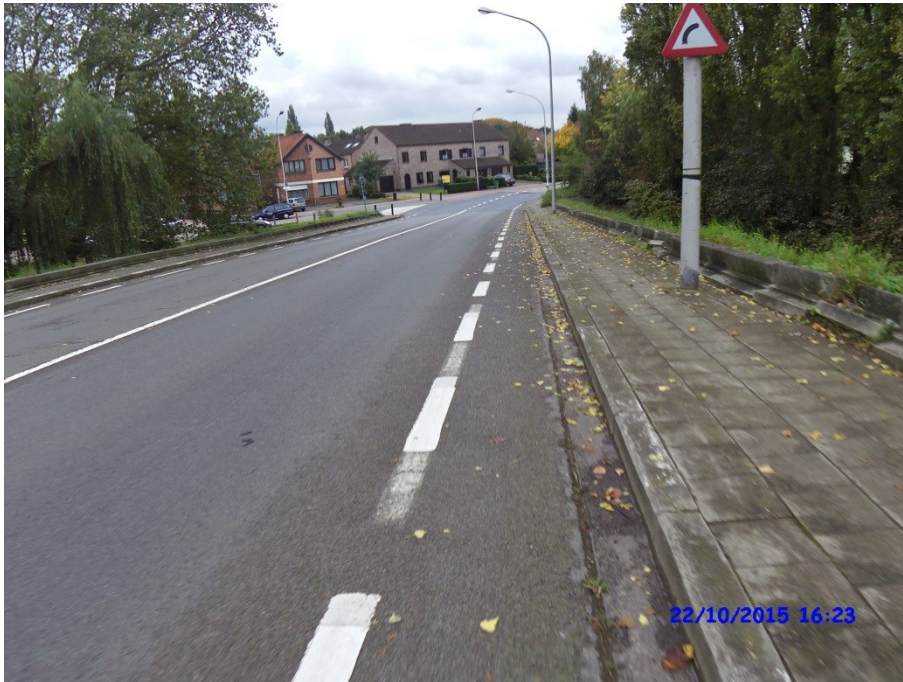
Figuur 10: Schriek (beide zijden van de rijweg) (zie ook Figuur 9 : 1): score 0,3/10 met 80cm breedte
