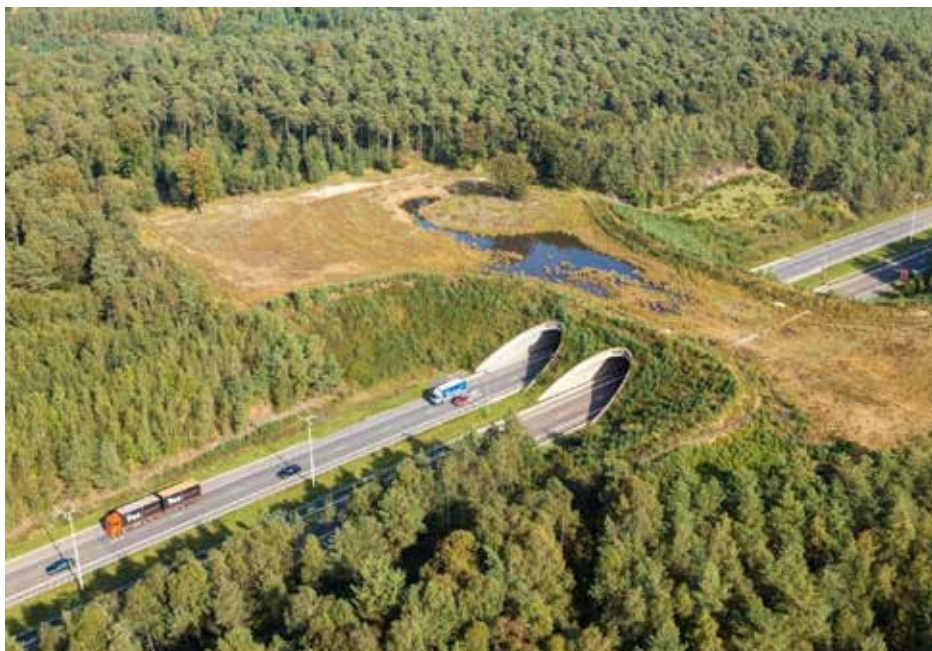
Referentieproject: Ecoduct Kikbeek over de E314 in Maasmechelen.
