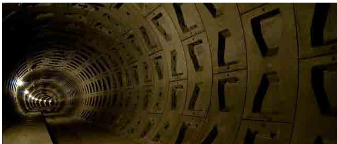
Figuur 105 : Zicht op een "slapende" premetro tunnel
